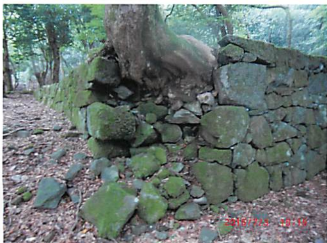
近世城郭を思わせる英彦山座主院下屋敷跡の石垣（農学部・彦山生物学実験施設）。巨木の根が石垣を崩しつつある。
